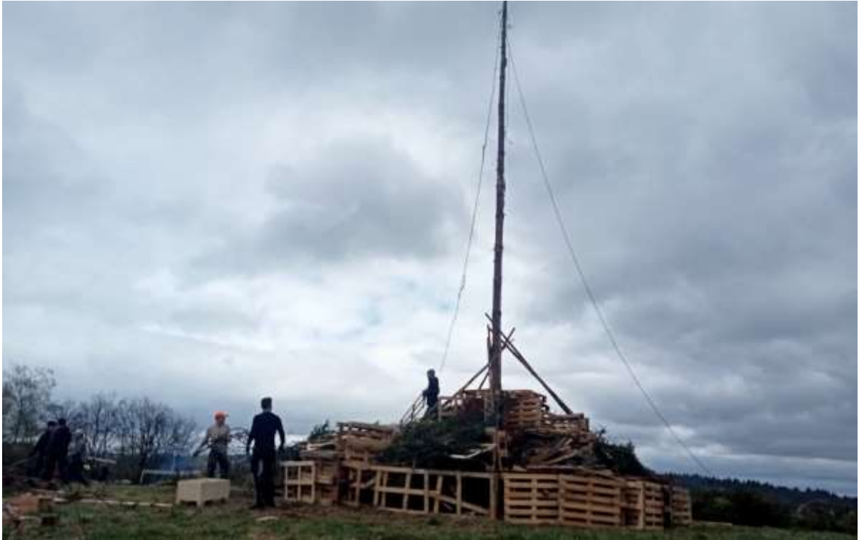
Der Baum steht und der Unterbau ist fertig.
